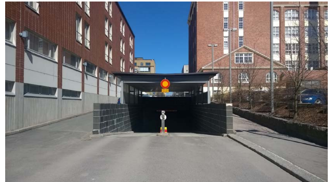
Attilan pysäköintilaitoksen nykyinen sisäänajo
