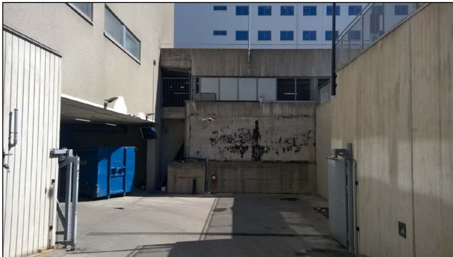
Pendolino-talon huoltotila. Tullintorin huolto täytyisi rakentaa samalla korkeustasolle, mikä ei onnistu ilman alemman pysäköintitason syventämistä ja pysäköinnin poistamista
